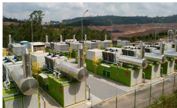
FIGURA 24 - APROVEITAMENTO ENERGÉTICO DO BIOGÁS EM ATERRO SANITÁRIO OPERADO PELA SOLVÍ ESSENCIS.
