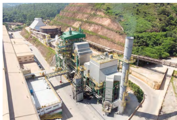
FIGURA 39 - CALDEIRA A BIOMASSA SUBSTITUI QUEIMA DE ÓLEO E GÁS NA PRODUÇÃO DE ALUMÍNIO DA CBA
