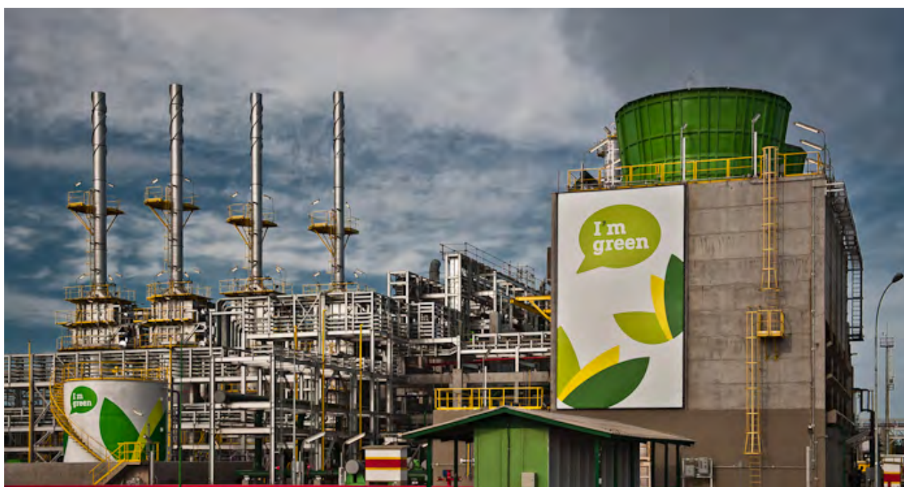
FIGURA 61 - PLANTA DE ETENO VERDE DA BRASKEM, NO RIO GRANDE DO SUL
